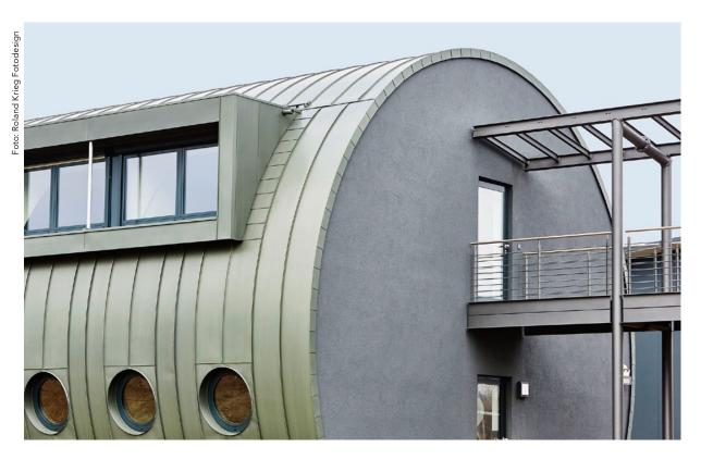
Fassadeneinteilung mit unterschiedlichen Bandbreiten: Die unteren Schare orientieren sich an der Position der Bullaugen, während die ungestörte Fläche oberhalb der Gauben Schare mit gleichmäßiger Breite erhielt. Rechts der Übergang zur Geschäftsführung
