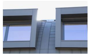
Details an den Gauben mit dezenter Entwässerung des Gaubendachs und mit der Schuppendeckung zur Aufnahme der thermischen Längenänderungen. Die Gauben wurden mit einem selbst entwickelten Steckleistensystem bekleidet
