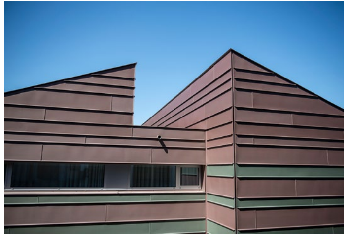
Der Farbwechsel an der Fassade sowie die beiden gegeneinander gestellten Pultdächer erzeugen eine gewisse Leichtigkeit
